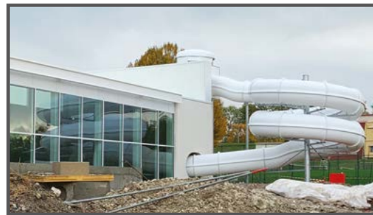
Mise en place du toboggan
