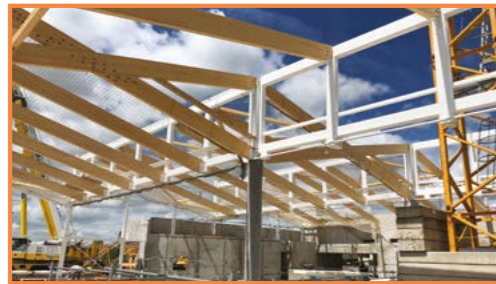
Pose de la charpente
