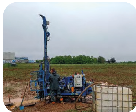
Foreuse SIDIRILL SD200 pour l'investigation de l'indice 25 au Puceuil © For et Tech
