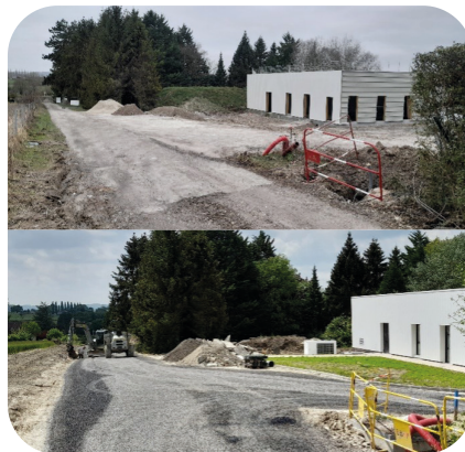
Evolution du chantier de voirie assuré par EBTP Lhotellier entre janvier et juin 2024 © CBE
