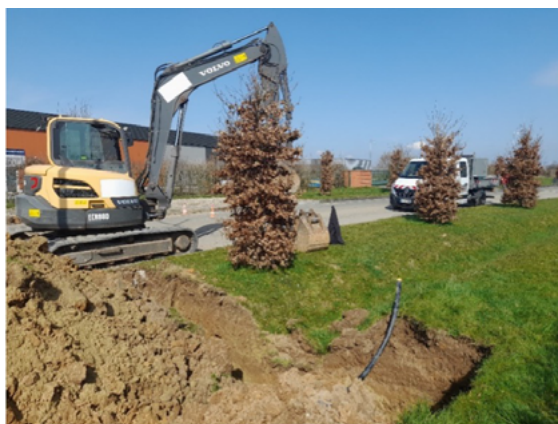
Travaux de défense incendie sur la ZAE des Hayons - mars 2022 © CBE
