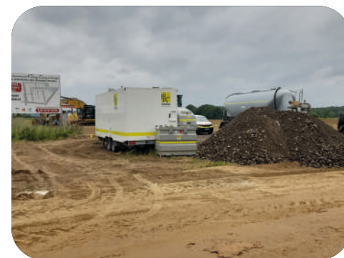
Début des travaux sur la Zone d'Activités des Grandes-Ventes - 27 mai 2025
