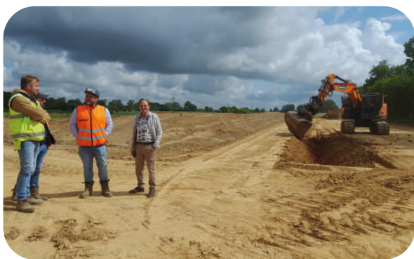
Démarrage des travaux de la Zone d'Activités des Grandes-Ventes - mai 2025 © CBE
